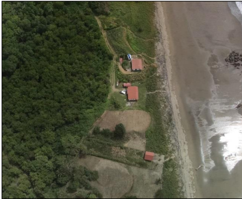
Imagen 4: área intervenida con edificaciones de viviendas (coordenadas 597813.63 Este, 821566.43 Norte)
