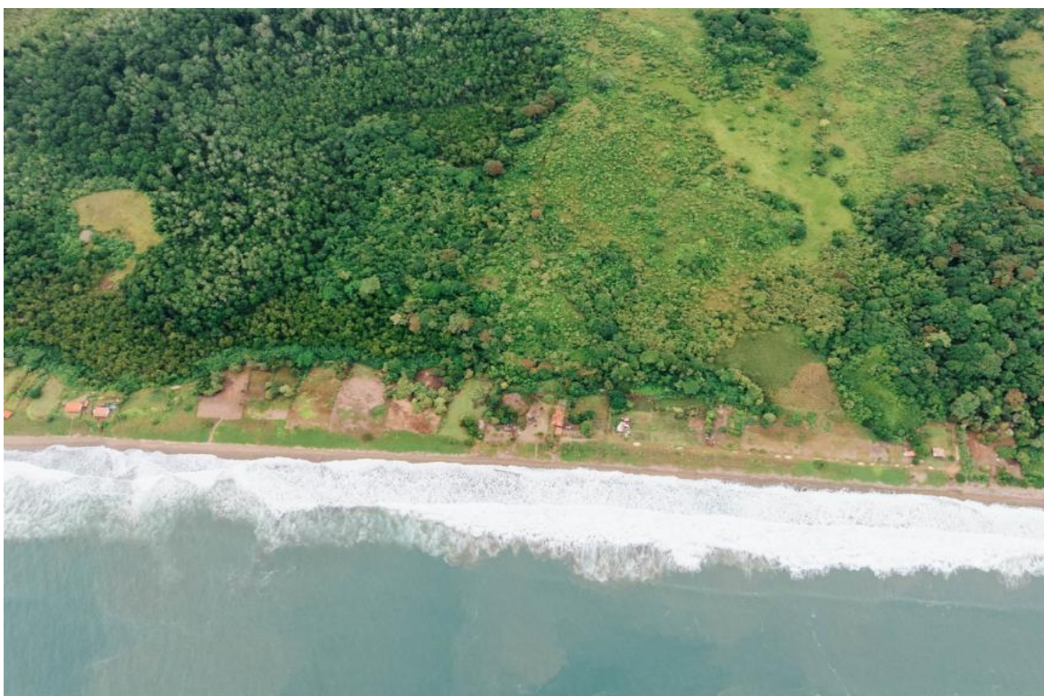
Imágenes aéreas tomadas en la tarde del día martes 26, durante evento de aguaje y mar de fondo. Se aprecia la amplitud hasta donde llega la marea alta.
